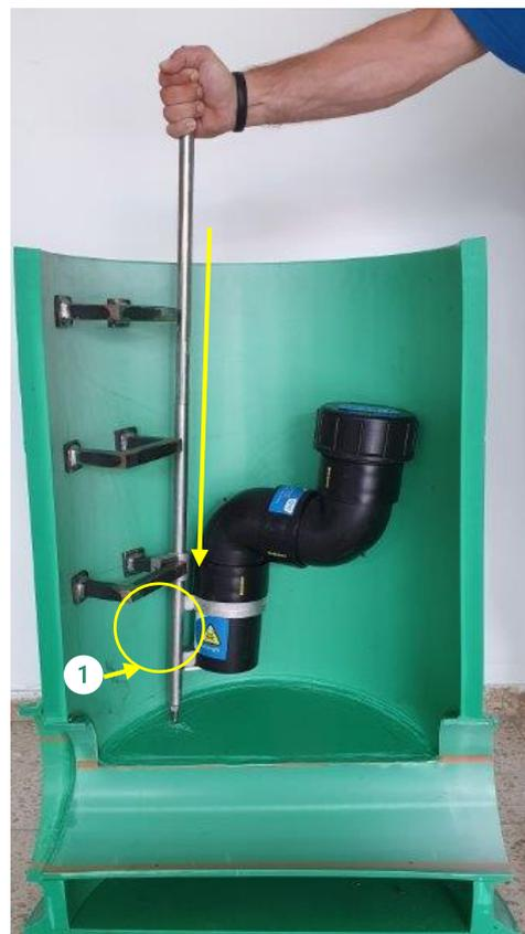
Den Steigeisen- Haltewinkel an der Seite des untersten Steigeisens ① einhängen. Der Halter soll locker sitzen, es ist keine Befestigung erforderlich. Dies dient zur Lagesicherung bis zum nächsten Arbeitsschritt.
