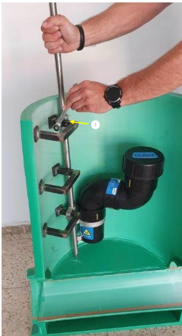
Zweiten Steigeisenhalter ① seitlich an dem Steigeisen mit beiden Schrauben festziehen.
