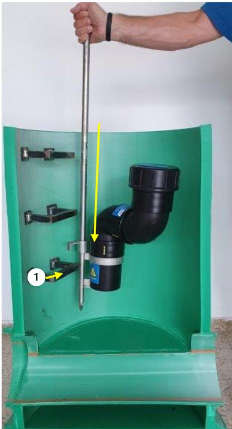
Entfernen Sie als erstes die Schrauben von dem Steigeisen- Haltewinkel ①. Danach diesen von oben auf den Rundstahl aufschieben. Dann das System von oben in den ersten Steigeisenhalter **seitlich einhängen**
